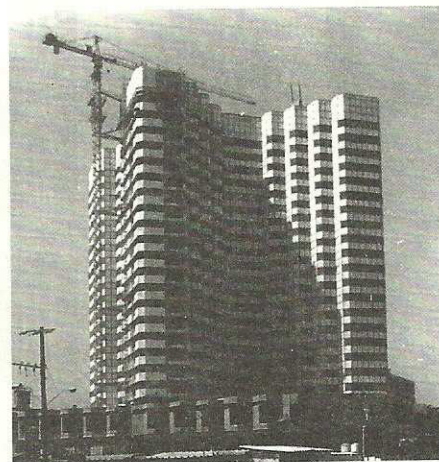
Hotelneubau in Havanna
