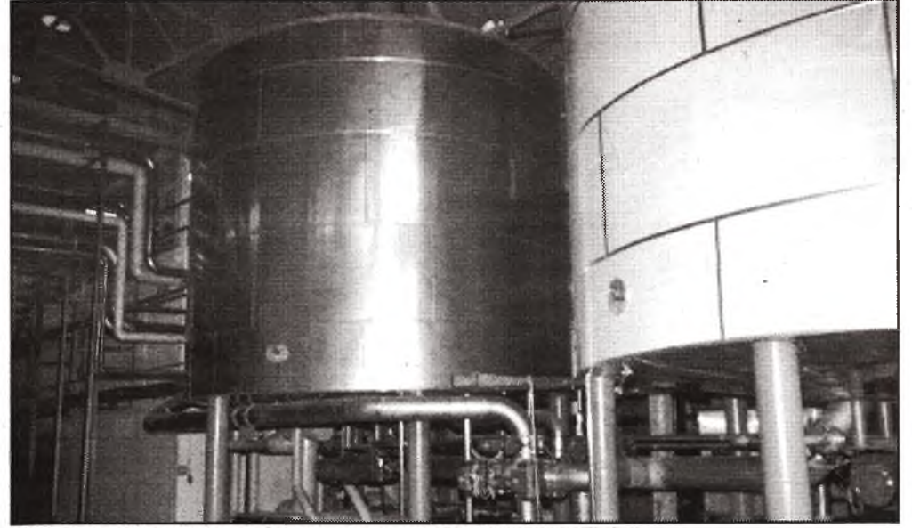
Die Firma Huppmann errichtete das neue Sudhaus von Tinima.
