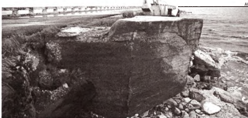
Die Wasserleitung, die die Hotels auf den nördlichen Cayos von Villa Clara versorgt, wurde stark beschädigt, aber ihre Reparatur ist schon abgeschlossen.
