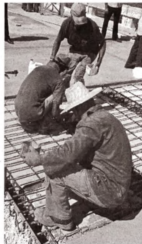
An der Reparatur des Dammes, der die Cayos von Caibarién mit Villa Clara verbindet, wurde hart gearbeitet.
