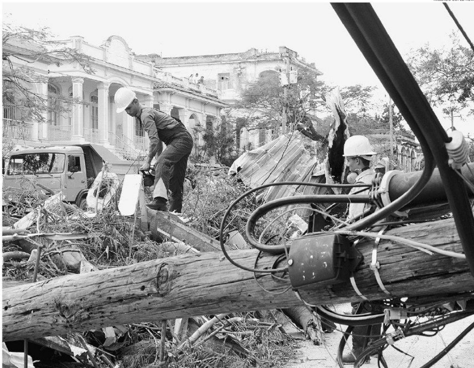
Unverzüglich wurde mit den Aufräumarbeiten begonnen
