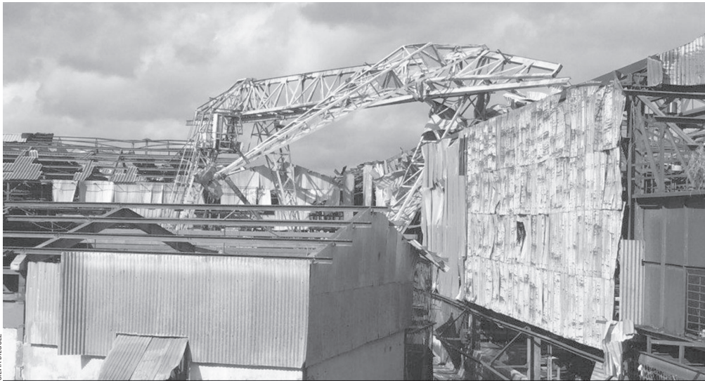
Die Anlagen der Fabrik Cubana de Acero, die sich an der Grenze der Stadtbezirke Diez de Octubre und Cerro befindet, wurden durch die Intensität der Winde stark beschädigt
