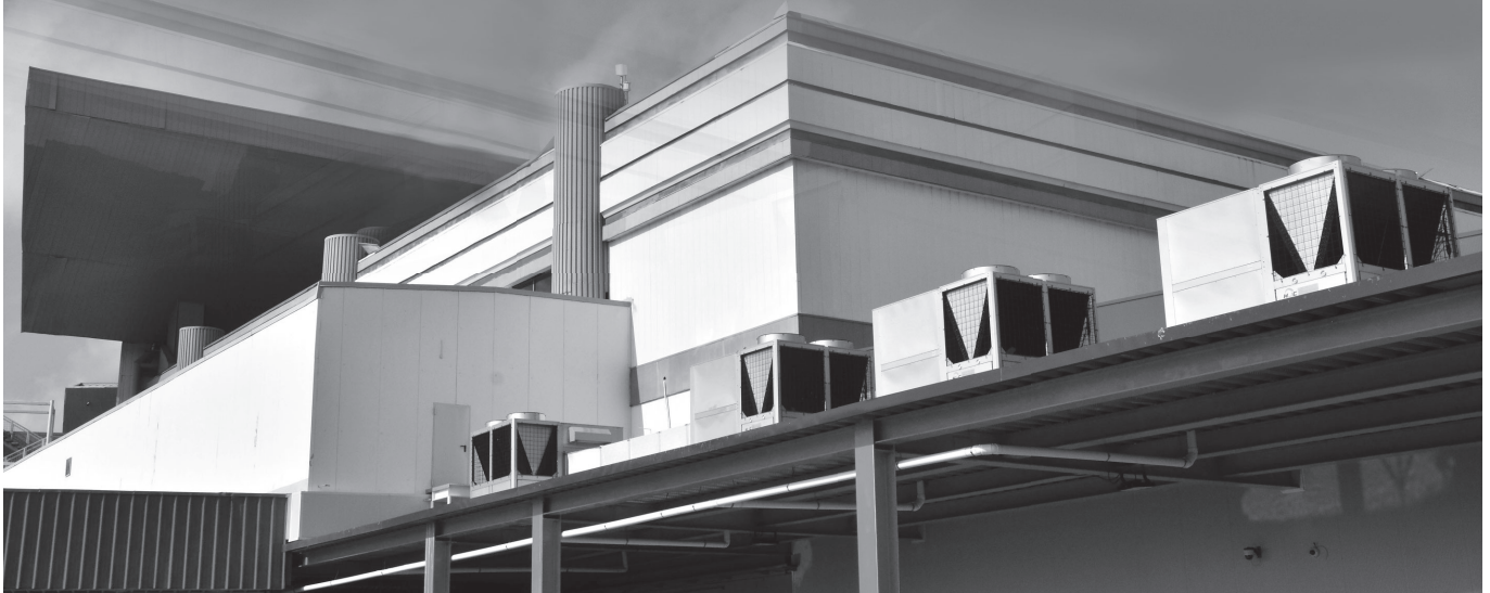
Zehn Dachklimageräte wurden installiert, die für einen besseren Luftstrom sorgen. FOTOS: RICARDO LÓPEZ HEVIA
